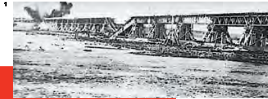
1 Высокий мост через Неву на Дороге Победы был открыт 19 марта 1943 года, а уже 25 марта два его пролета были разрушены в результате артиллерийских обстрелов. Восстановили мост всего за 15 дней
